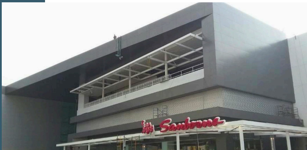
Plaza Tlanepantla - Fachada e interior Suministro e instalación de panel de aluminio.
