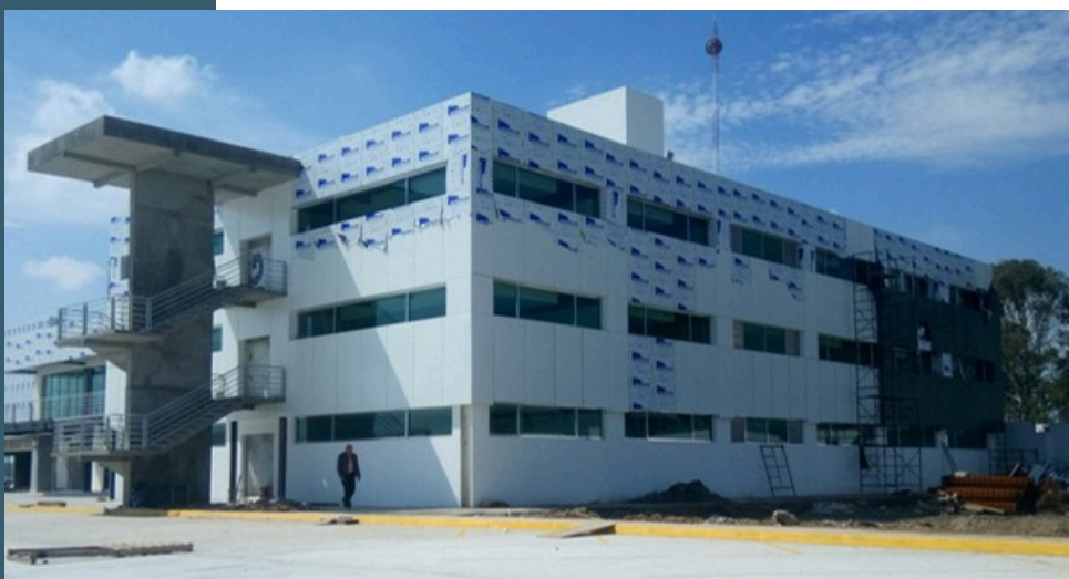
Universidad de Salud Toluca Suministro e instalación de panel de aluminio.
